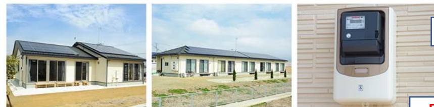
集会所 (防災拠点) ソーラー付 (PV9.1kW)
