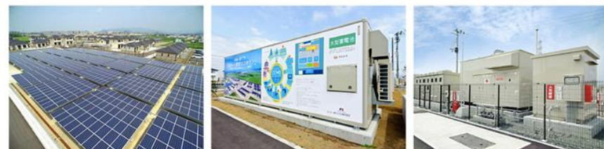
防災調整池ミドルソーラー(400kW)
